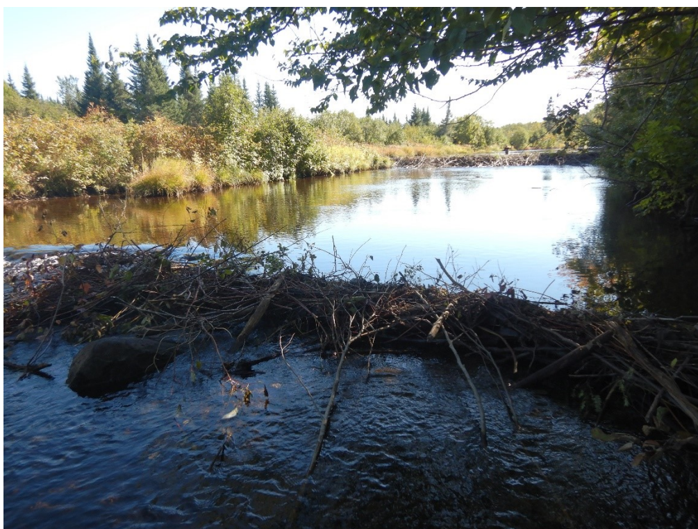
Photo 4. Configuration en paliers amont-aval d'un complexe de deux barrages au site du barrage 2. Vue vers l'amont.
