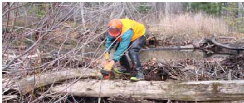
Enlèvement des débris et barrage de castor inactif
