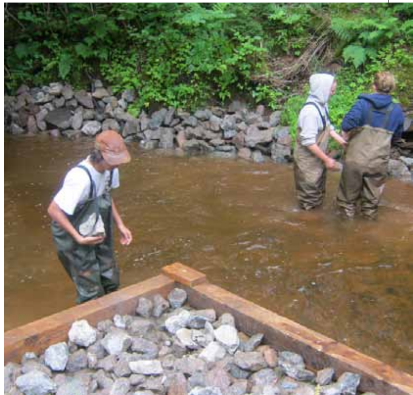
Installation d'un déflecteur Photo: FCSA
